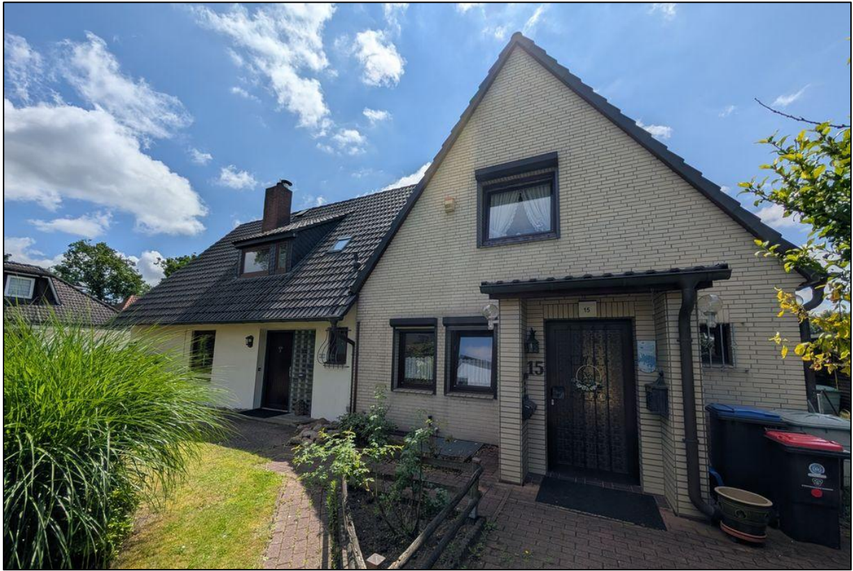
Eingangsansicht des kleineren Hausteils (Haus 2)
